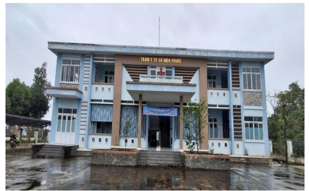
Hình 20. Trạm Y tế Điện Bàn Tây 2
