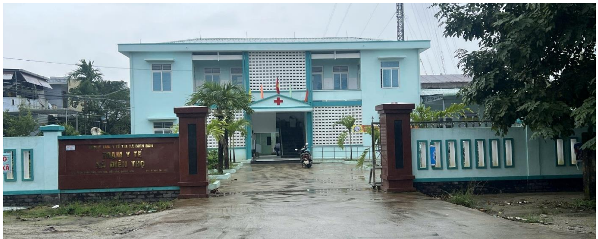
Hình 21. Trạm Y tế Điện Bàn Tây
