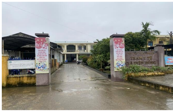
Hình 19. Trạm Y tế Điện Bàn Tây 1
